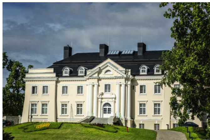
Pałac w Komierowie, Fot. Pałac Komierowo
